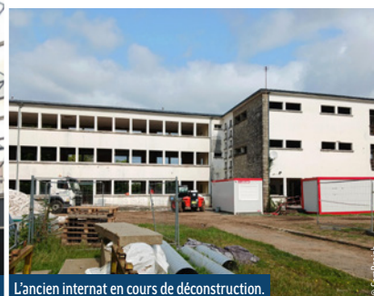
L'ancien internat en cours de déconstruction.
